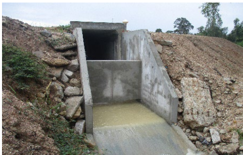
ภาพที่ 2-9 ประตูระบายน้ำและอาคารสลายพลังงาน (Stilling Basin)
