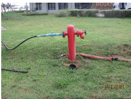
ภาพที่ 2-24 หัวจ่ายน้ำดับเพลิง ตามแนวถนนของพื้นที่โครงการ
